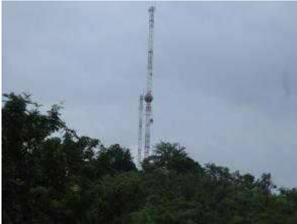
Photo 33 : Vue d'une antenne de télécommunication à Kpéssidè
