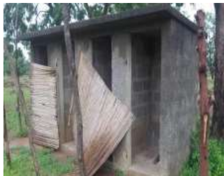
Photo 19 : Sanitaire opérationnelle au Lycée de Broukou
